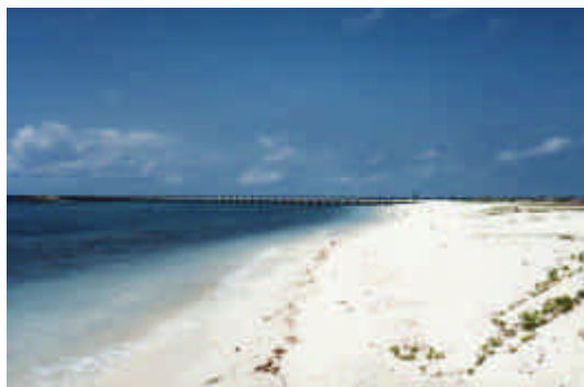
白色沙灘與後方廢棄的舊棧橋，棧橋上木板已腐壞一空，只剩水泥骨架，要走到尾端去釣魚需要一點勇氣
