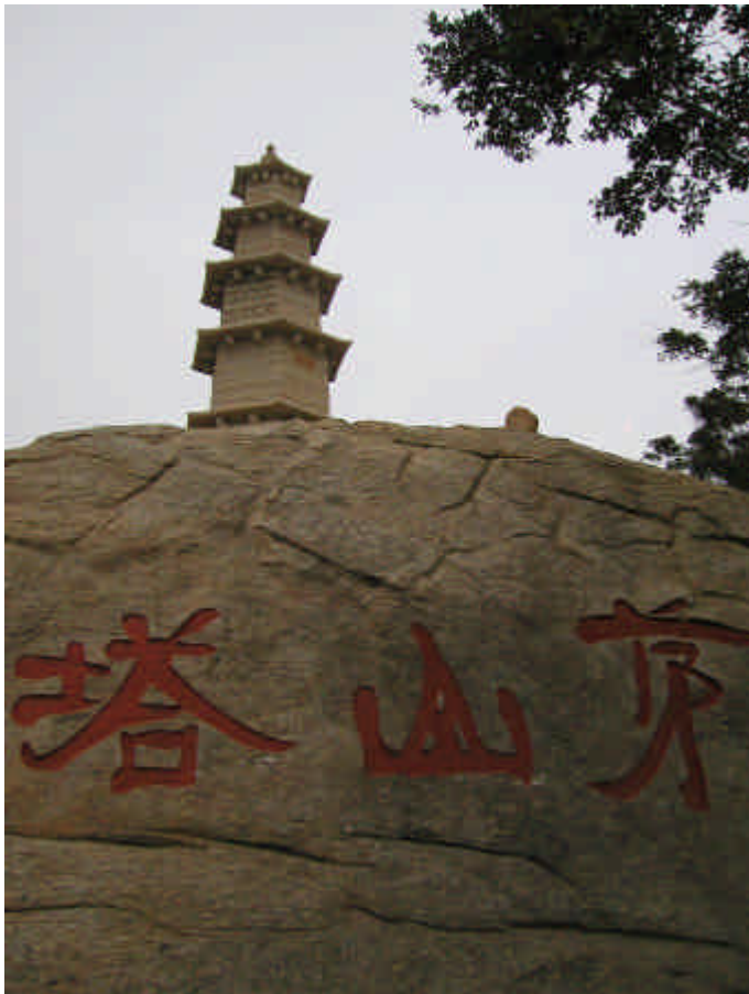
已完工的茅山塔。 2005.1.30 攝於茅山塔
